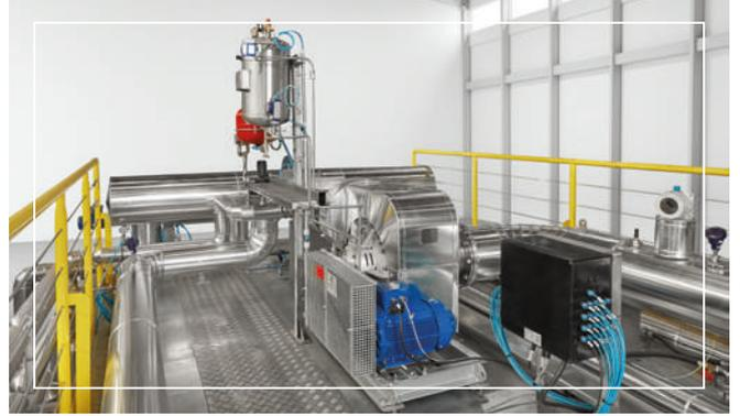
**Module de pompe à vide:** Nous utilisons la meilleure technologie pour le système à vide : la technologie de pompe à anneau liquide. Les pompes ont une longue durée de vie et sont dimensionnées pour fournir un vide efficace dans des conditions de sécurité.
